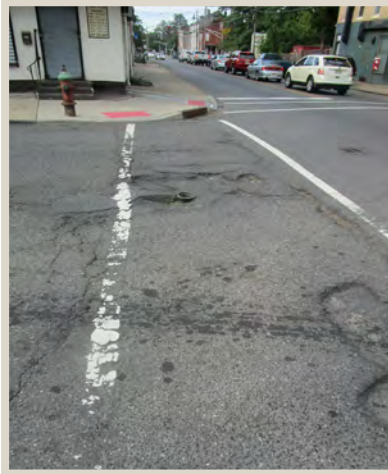
Figure 45. Uneven asphalt.
