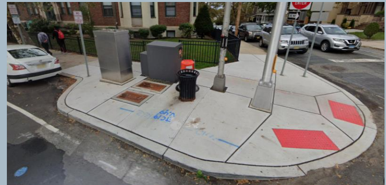
Top: Washington Ave, Carlstadt (Bergen County) Bottom: JFK Blvd, Jersey City (Hudson County)
